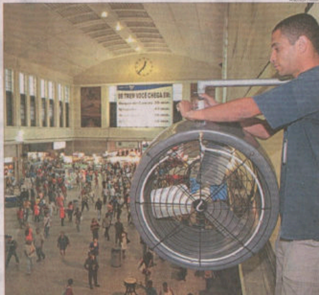
TECNICOS instalaram ontem, na Central, ventiladores e chuveirinhos para espalhar água pelo saguão principal
